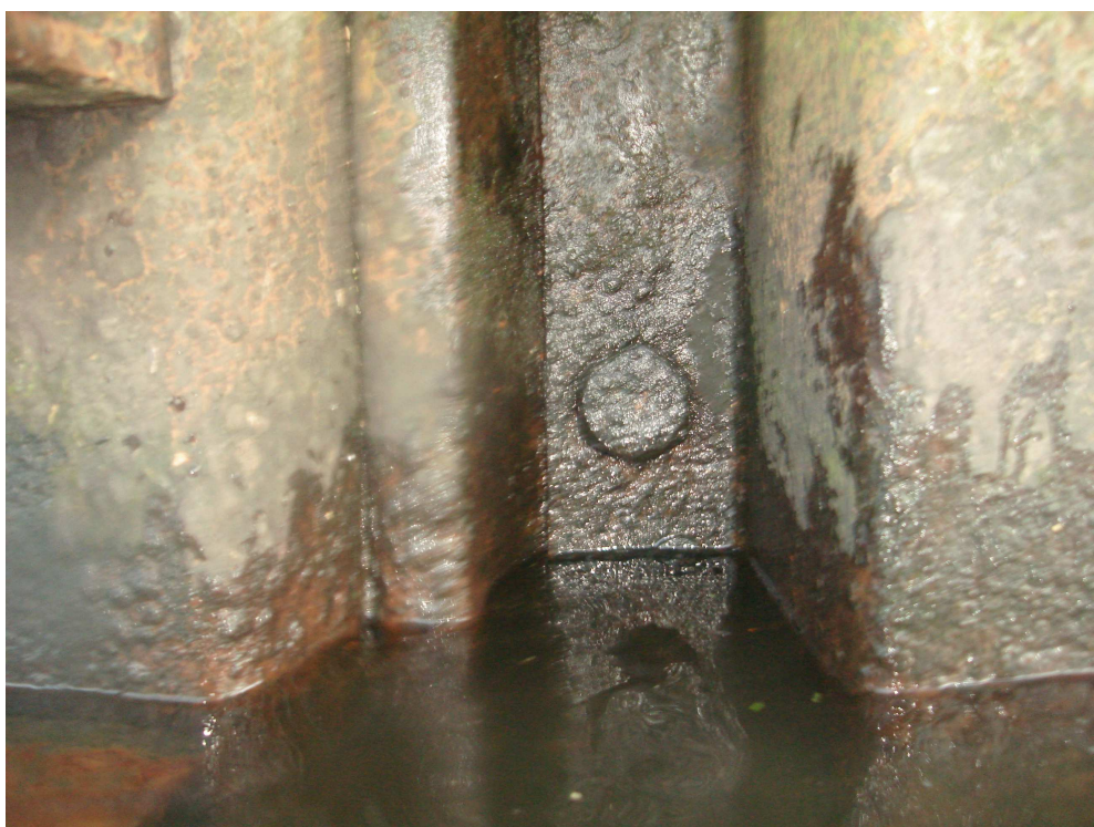
Zdjęcie nr 8 – zmiana ścianki szczelnej z Larssen III na Hoesch III
